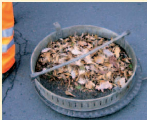
So sieht es aus, wenn ein Kanaldeckel geöffnet wird: Laub und Unrat füllen den Metallkorb und schützen den darunter fließenden Kanal.
